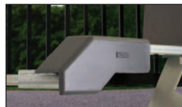
tapadera que protege la junta ayuda en eliminar puntos de pellizcos
